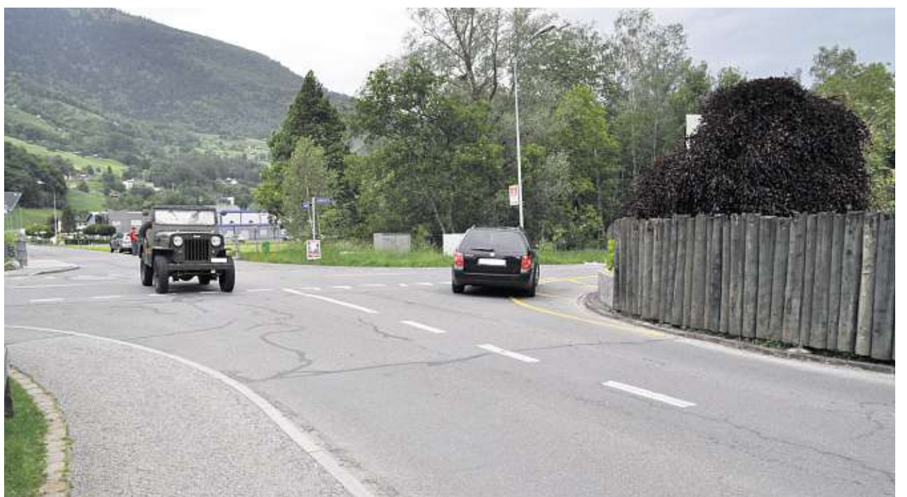
Wird bis Ende 2013 sicherer: Die Härtikreuzung in Vilters vor der Sanierung.
